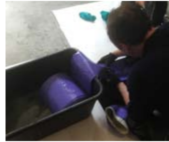
”Strumpan förs in och blåses upp inuti det gamla röret, stelnar och blir som ett nytt rör.”
