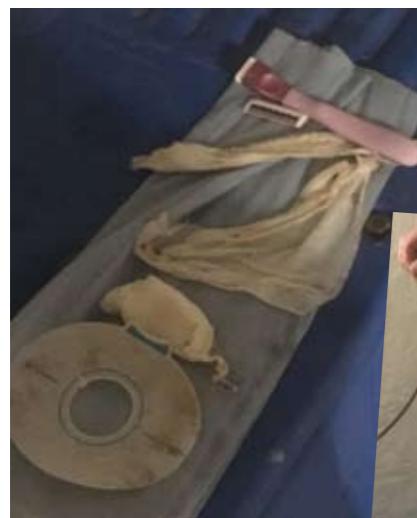
Varje dag har de föremål som orsakat maskinhaveri och översvämningar fotografertas.
